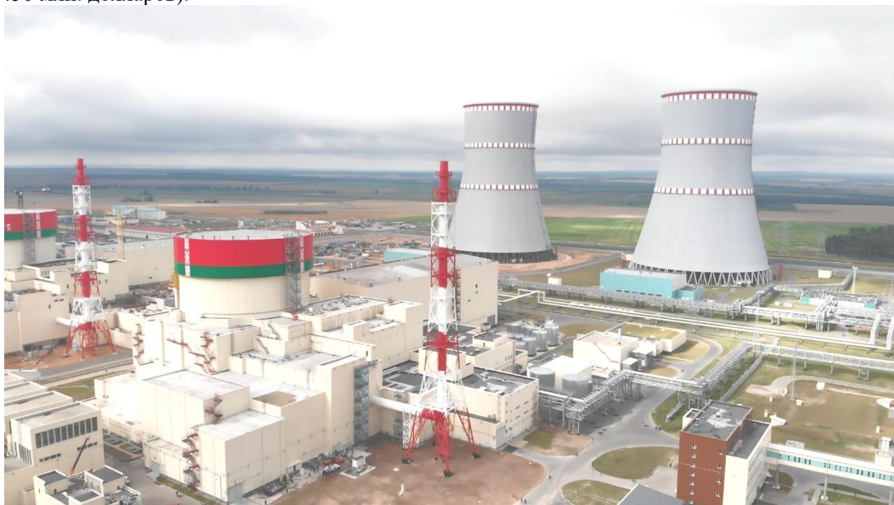
Рисунок 1. Белорусская атомная станция
